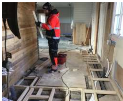
Köket under rivning och uppbyggnad
